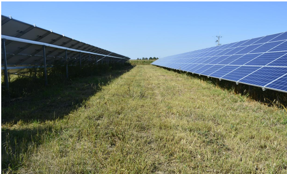
Fot 1. Typowa droga technologiczna pomiędzy rzędami paneli – stanowi ją pas gruntu o szerokości umożliwiającej przejazd pojazdu [fot.: Krzysztof Kręciproch]
